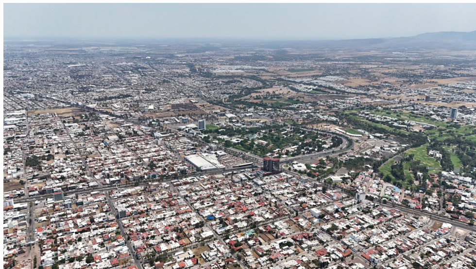
Cuadro 1. Vista aérea de Aguascalientes tomada con dron DJI FC4828 el 2 de junio de 2024
