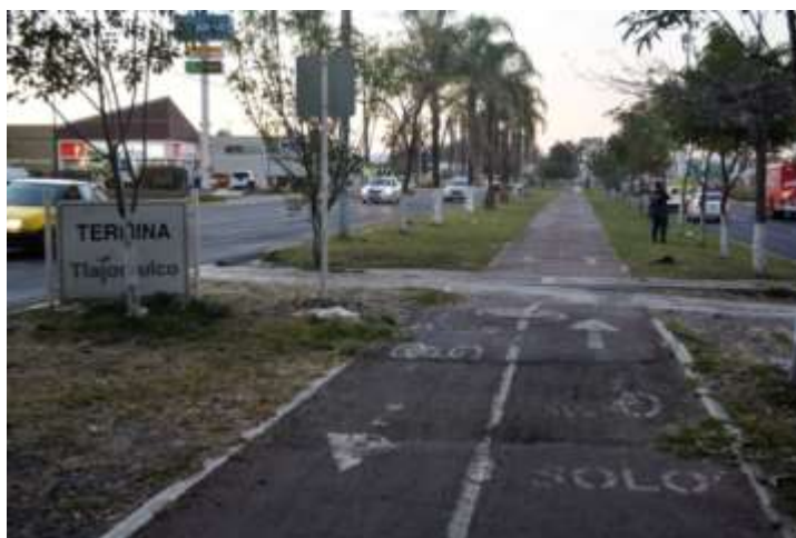
Imagen 1. Desgaste en las señalizaciones horizontales de la ciclovía de Adolf. B. Horn
