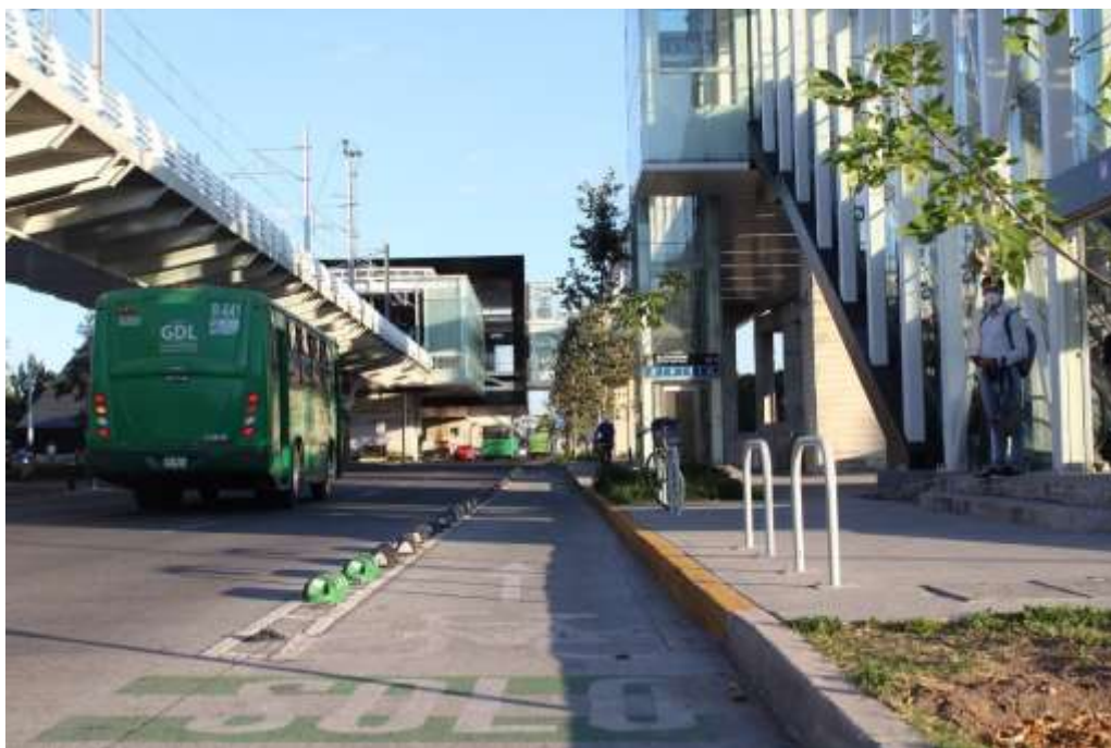
Fotografía 3. Área 3. Entrada de la estación Plaza Patria por Av. Ávila Camacho en sentido “Central camionera”
