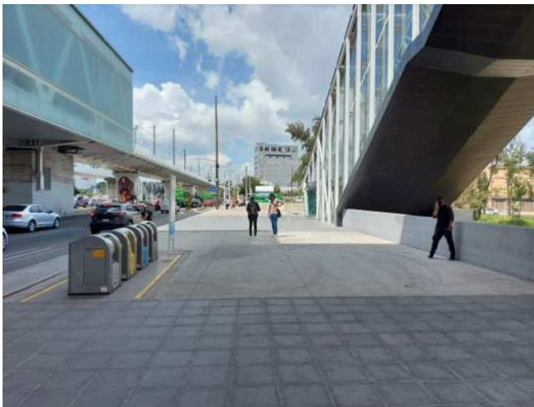
Fotografía 4. Área 4. Entrada de la estación Plaza Patria por Ávila Camacho en sentido “Periférico Belenes”
